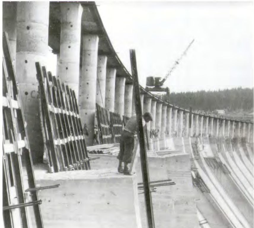
Bauarbeiten an der Eupener Talsperre 1946
