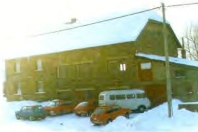
Medell-Hochkreuz, 1972: In diesem Privathaus war die Beschützende Werkstatt in den ersten Jahren untergebracht.
